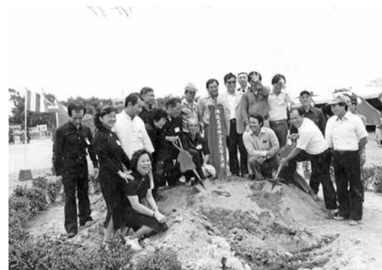
1984年4月24日花蓮慈濟醫院第二次動土興工，地點在醫院現址。鄧淑卿在前排左蹲在土堆上。
